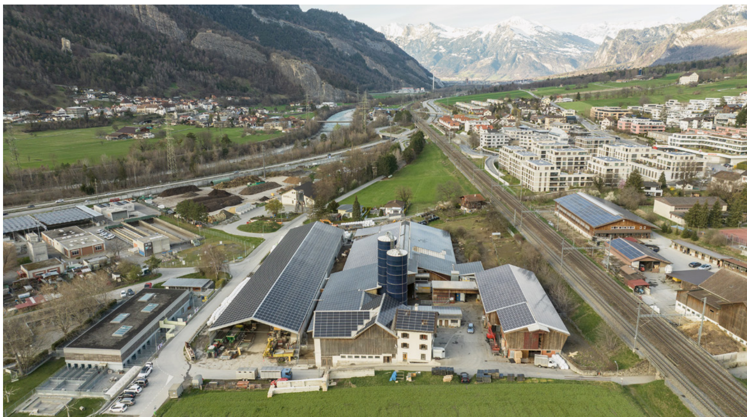
Die Dächer des Mehli-Hofs in Chur sind komplett mit PV-Panels belegt. Auf den umliegenden Liegenschaft liegt dagegen noch viel Potenzial brach.
